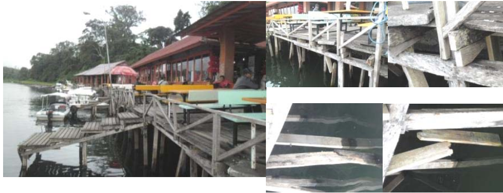
Gambar 3. Kondisi dermaga di Danau Batur, Bali.
