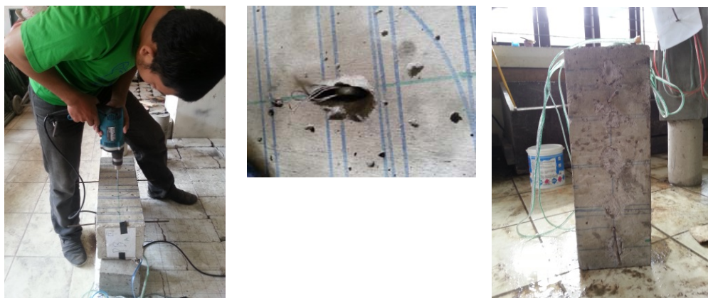
Gambar 4. Proses pemasangan pen-binder
