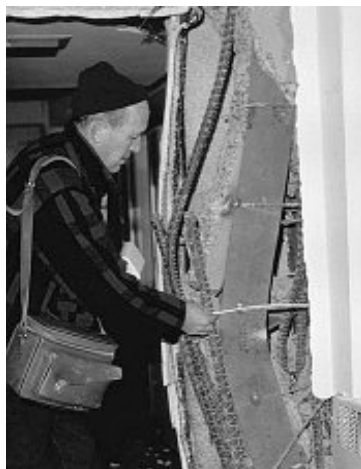
Gambar 2. Kegagalan kolom karena tekuk [Sumber : http://www.arch.virginia.edu ].
